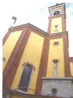
Abside dopo i lavori
