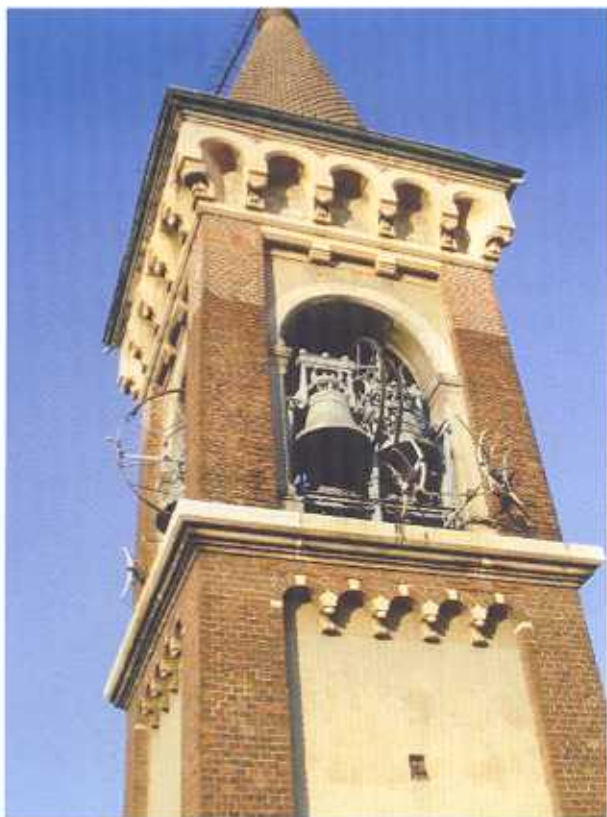
...e come appariva prima dei lavori
