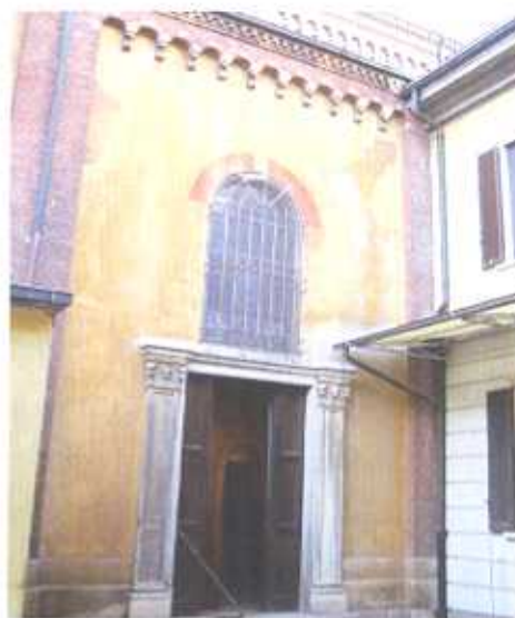
...e prima dei lavori
