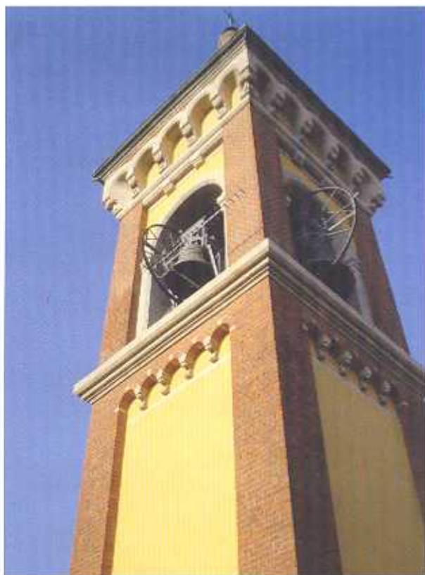
Il campanile dopo i lavori di restauro ...
