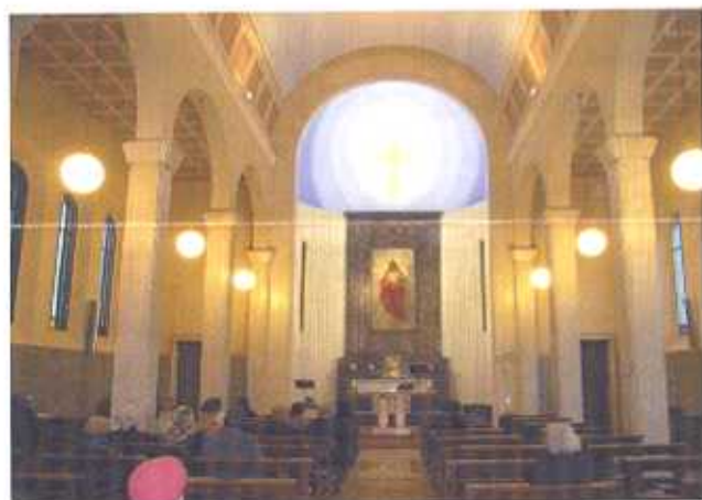
Veduta verso l'altare dopo i lavori...
