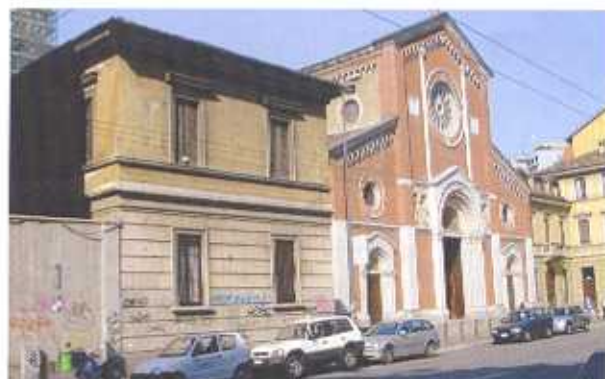
...e prima dei lavori
