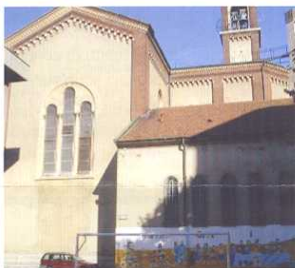
...e prima dei lavori
