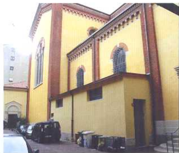
Veduta dal cortile parrocchiale dopo i lavori ...
