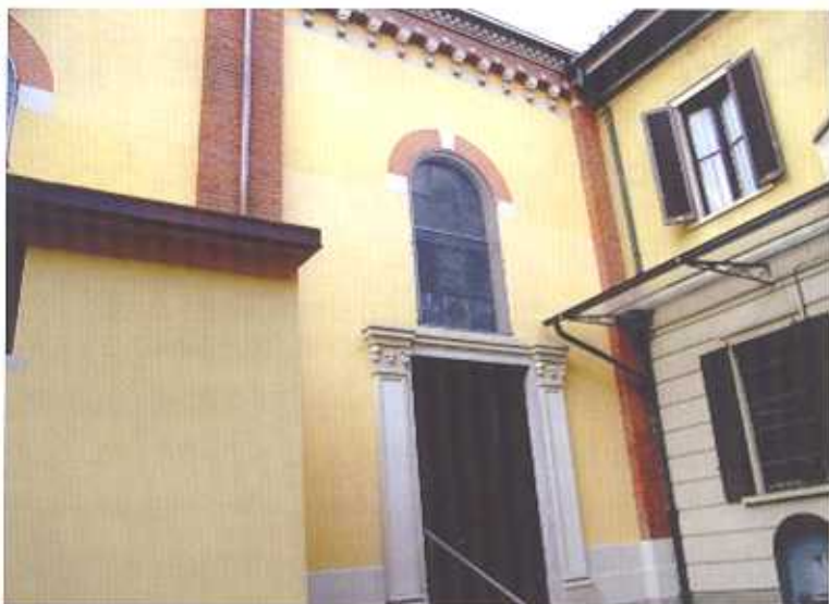
Veduta sul cortile parrocchiale dopo i lavori ...
