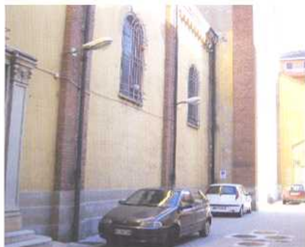
...e prima dei lavori
