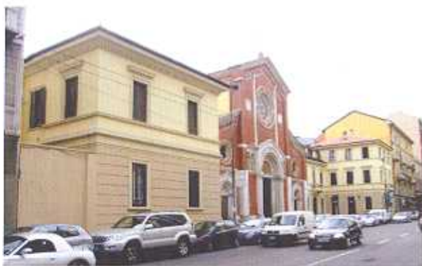
Veduta d'insieme dalla strada dopo i lavori...
