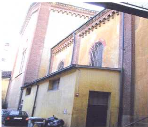
...e prima dei lavori
