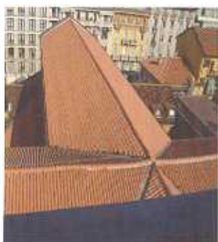
I nuovi tetti della chiesa
